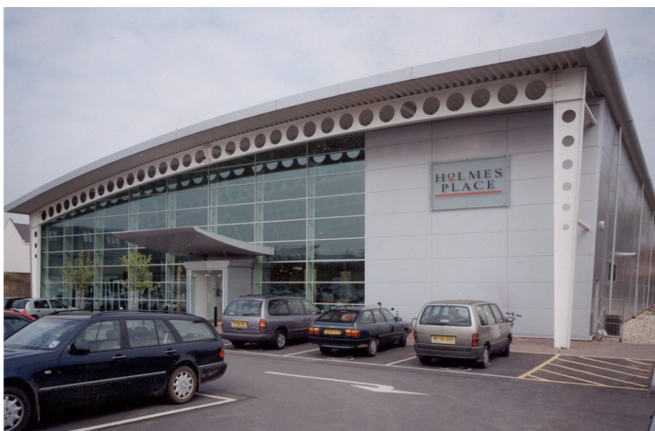
Obrázek 3.3 Perforované prvky v rámové konstrukci
