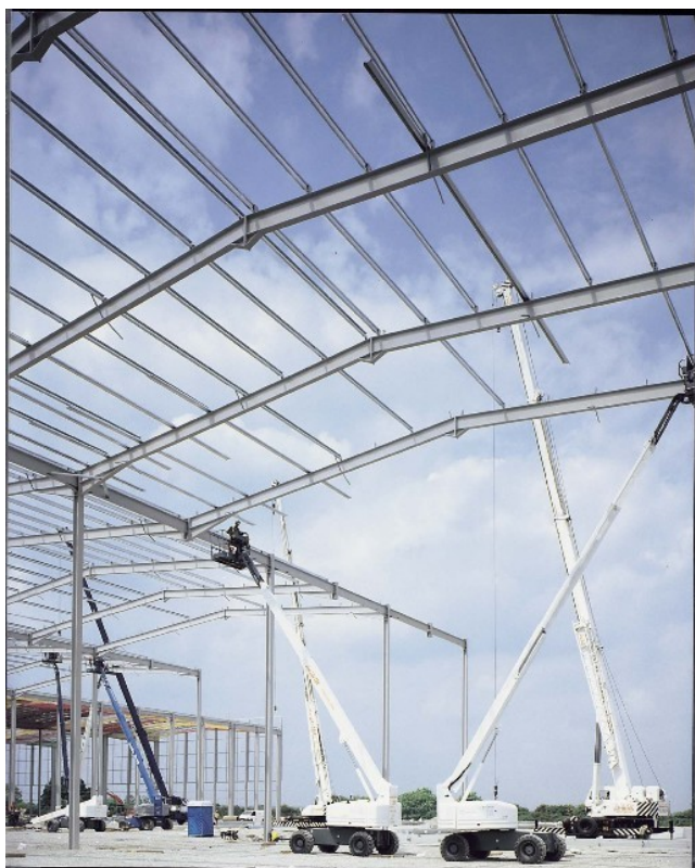
Obrázek 3.14 Montáž moderní rámové konstrukce
