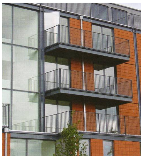
Obrázek 2.1 Balkóny z profilů válcovaných za tepla, využité na tenkostěnné konstrukci
