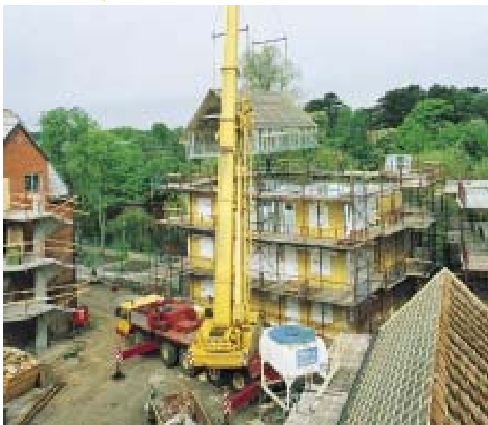
Obrázek 2.1 Prefabrikovaná část střechy během montáže (Zdroj: Lindab Profil AB)
