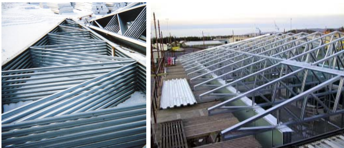
Obrázek 1.1 Typické tenkostěnné příhradové konstrukce mohou překlenout výrazná rozpětí (Zdroj: pravá fotografie -Lindab profil AB)
