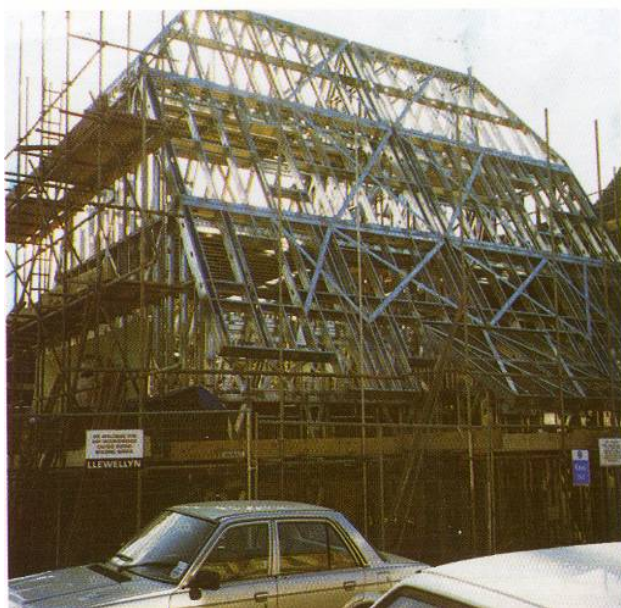
Obrázek 1.3 Mansardová střecha umožňuje ve střeše vytvořit třípodlažní byt
