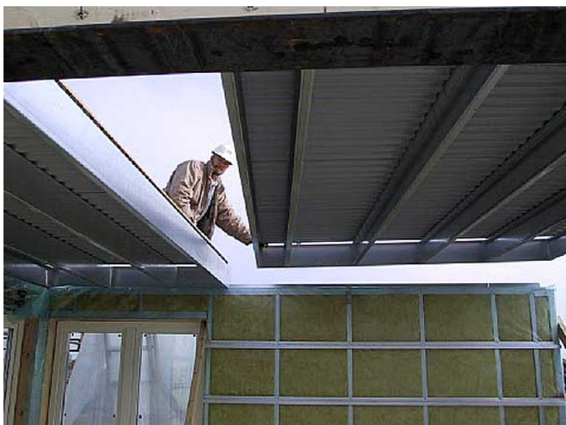
Obrázek 2.5 Montáž prefabrikovaných stropních dílů v závislosti na použitém způsobu vykládky, z Lindab Profil A
