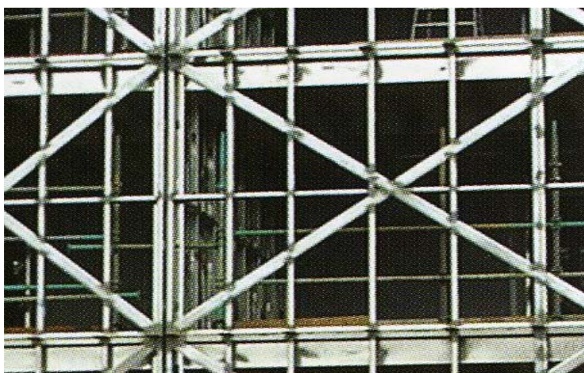
Obrázek 1.1 Příklad typické konstrukční stěny se ztužením X
