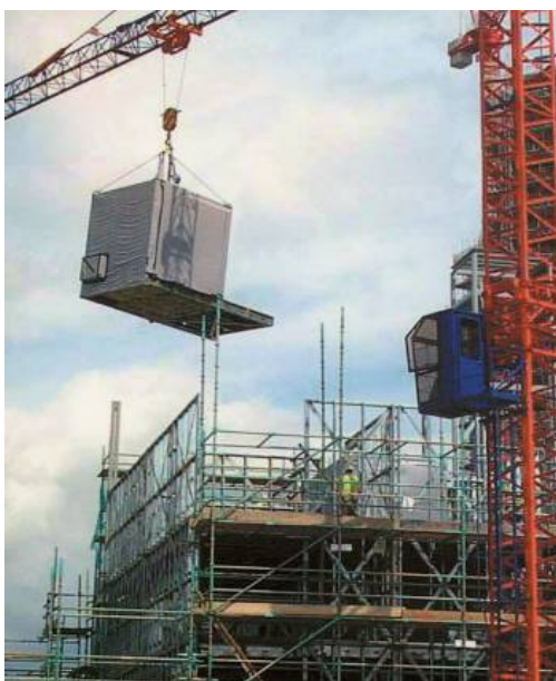
Obrázek 4.3 Koupelnové jádro zdvihané v Beaufort House, Londýn
