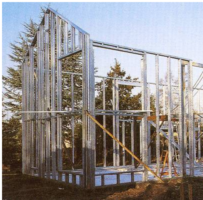
Obrázek 2.1 Obytná konstrukce složená z jednotlivých prvků
