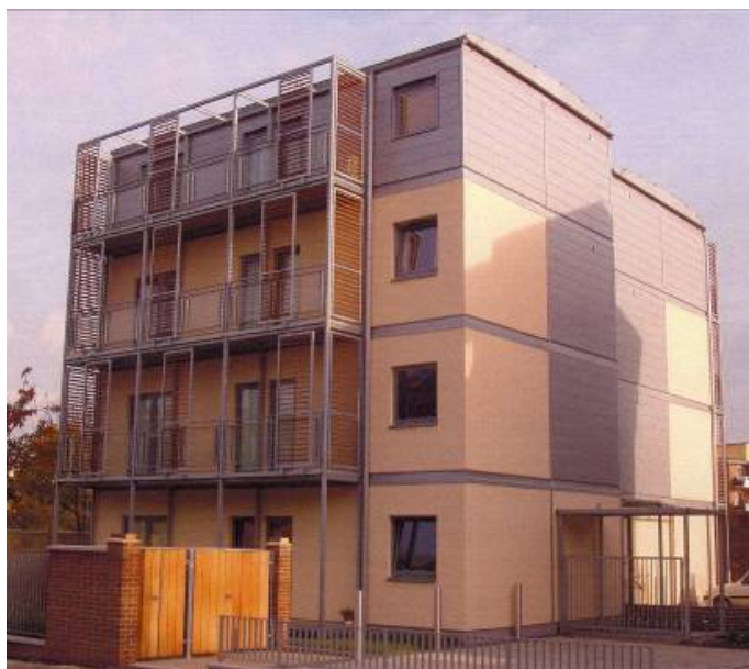
Obrázek 4.4 Moduly, které byly vyrobeny v Polsku a smontovány v Londýně
