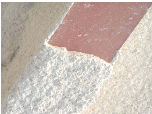
Obrázek 5.1 Detail pásnice průřezu s ochranou postříkem
