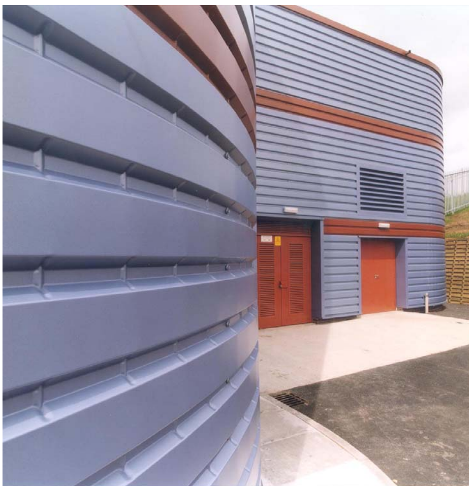
Obrázek 2.3 Opláštění průmyslové budovy z vodorovně pnutých a obloukových profilů (Fotografie s laskavým svolením Corus P & P)
