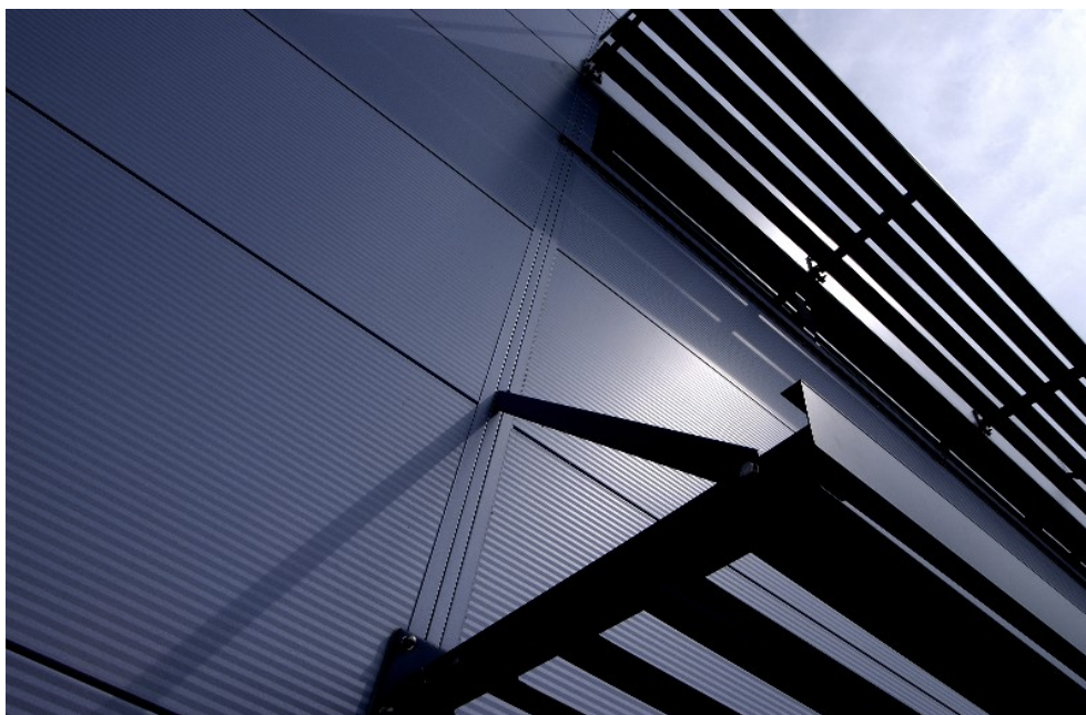
Obrázek 4.1 Opláštění kancelářské budovy vodorovně pnutými panely s malými výstupky (Fotografie s laskavým svolením Corus P & P)
