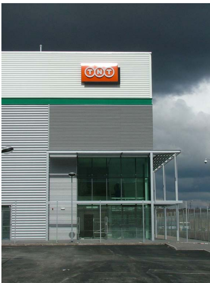
Obrázek 2.2 Skladiště a kancelářská budova má nápadný vzhled díky kombinaci opláštění z různých profilů s různými barvami (Fotografie s laskavým svolením Michael Sparks Associates)
