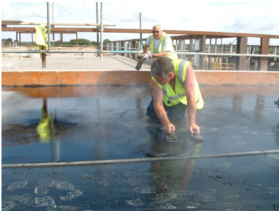
Obrázek 3.6 Litý asfalt na polyuretanových deskách s povrchem ze skelných vláken, které byly nejprve přilepeny horkou živicí k vrstvě parozábrany (Fotografie s laskavým svolením Permanite Asphalte)
