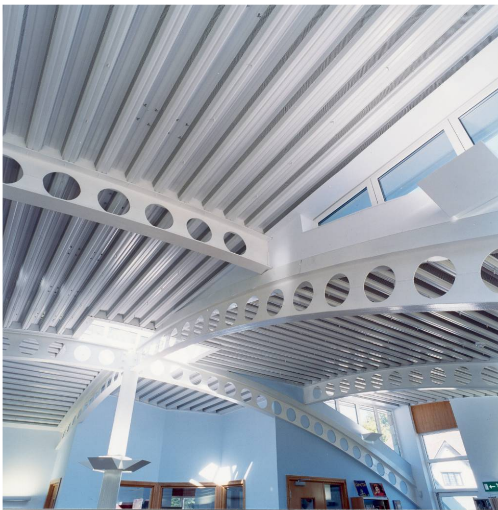
Obrázek 2.6 Střecha s vysokými trapézovými plechy podepřená systémem prolamovaných nosníků s tepelnou izolací z minerální vlny pro pohlcení hluku v knihovně (Fotografie s laskavým svolením Corus P & P)
