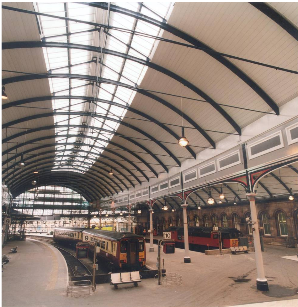
Obrázek 2.2 Pro renovaci střechy nádraží v Newcastle byl k vytvoření dojmu dřevěných prken použit jasně bílý lisovaný podhledový profil (Fotografie s laskavým svolením Corus Profiles & Panels)
