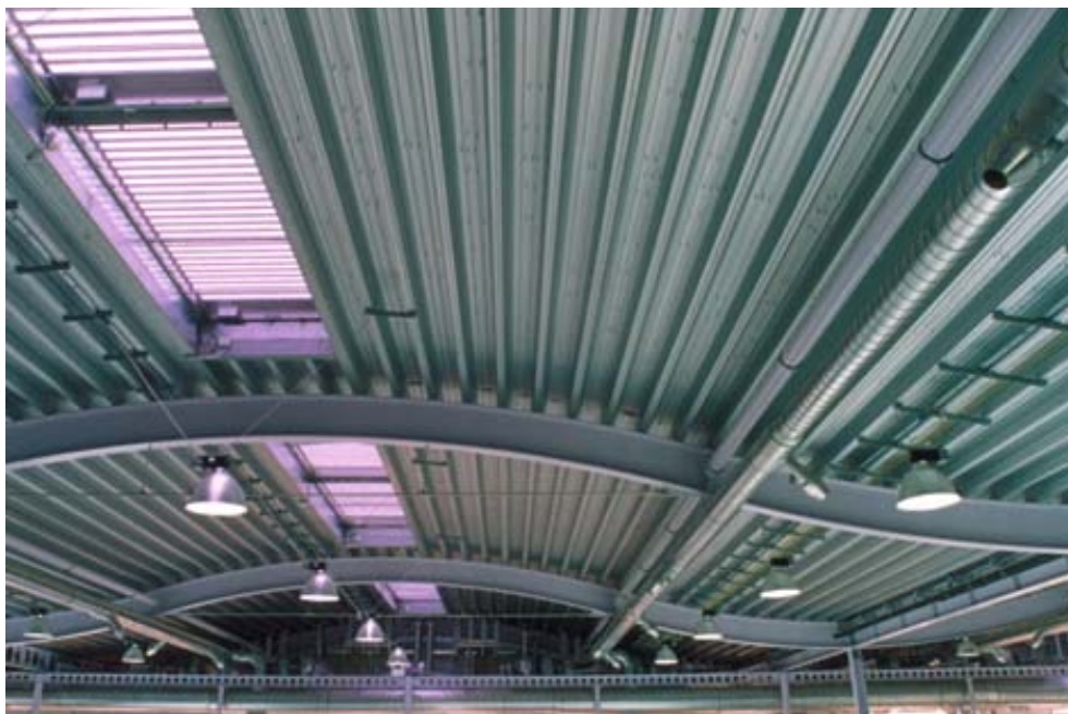
Obrázek 3.3 Nosná deska z vysokého profilu uloženého na příčné vazby (bezwaznicový systém) (Fotografie s laskavým svolením Wilkinson Eyre Architects. Foto Paul Rapson)
