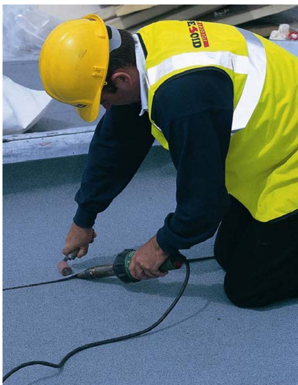
Obrázek 3.4 Skládaná živičná fólie těsněná svařováním (Fotografie s laskavým svolením Ruberoid)
