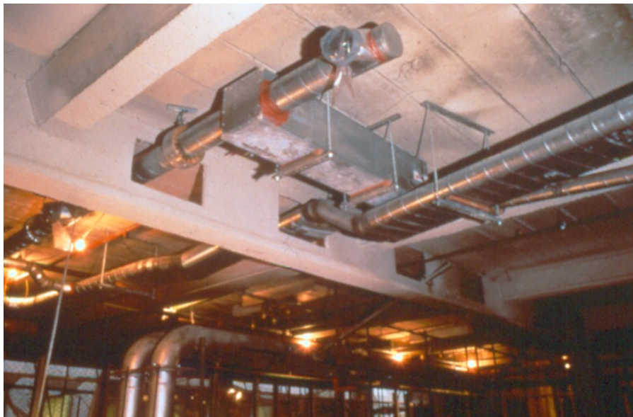
Obr. 2.2 Řada pravoúhlých otvorů u primárního nosníku
