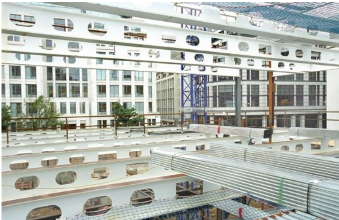
Obr. 3.3 Svařované nosníky pro velké rozpětí s variabilními tvary otvorů
