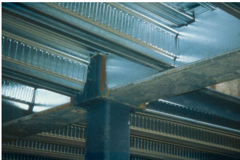
Obr. 1.4 Vysoké plechy a nosník typu "slim floor"
