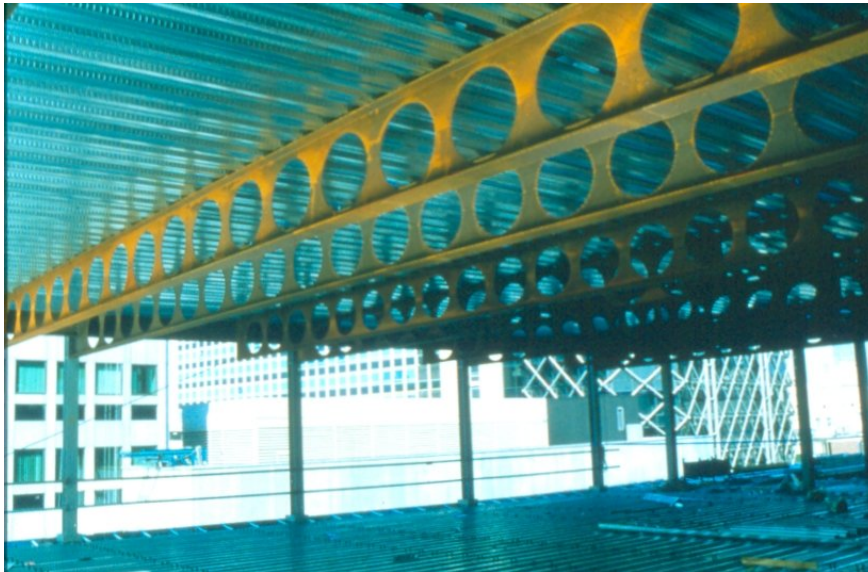
Obrázek 1.4 Nosníky s kruhovými otvory na velká rozpětí
