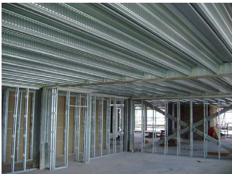
Obrázek 1.3 Konstrukce štíhlých stropů za použití vysokých plechů
