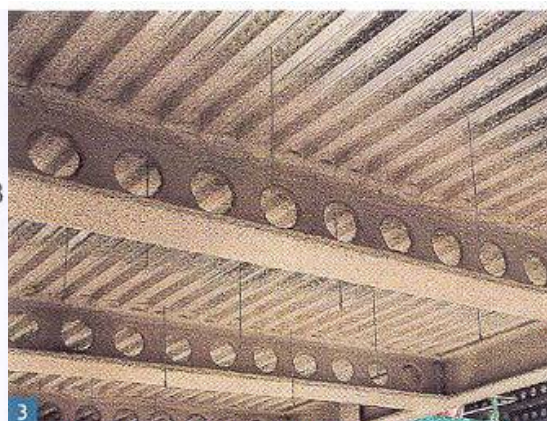
Obrázek 6.9 Typický nosník s kruhovými otvory [7]
