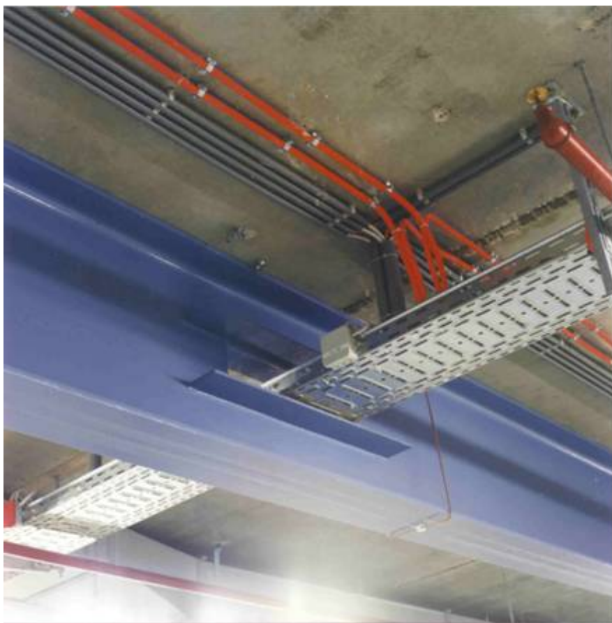
Obrázek 6.7 Nosníky s otvorem malé velikosti pro elektroinstalace [15]
