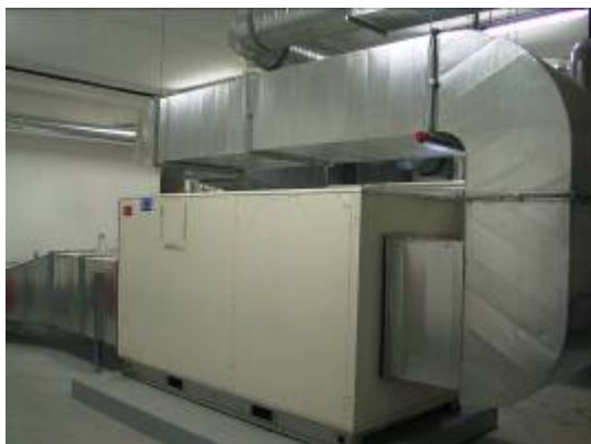
Obrázek 3.6 Typická místnost s VAV klimatickým systémem a dispoziční uspořádání na střeše budovy ukazující důležitost velkého prostoru pro potřeby systému
