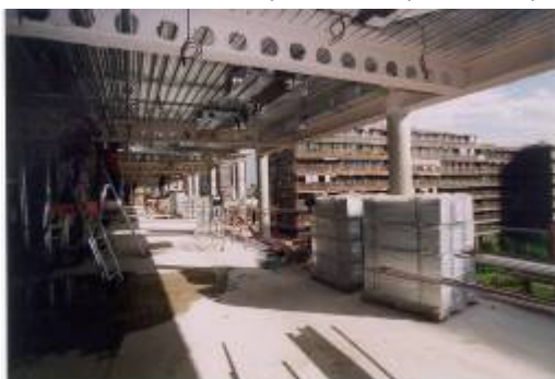
Obrázek 6.11 Nosníky s kruhovými otvory s rozvody procházejícími otvory ve stěnách [15]
