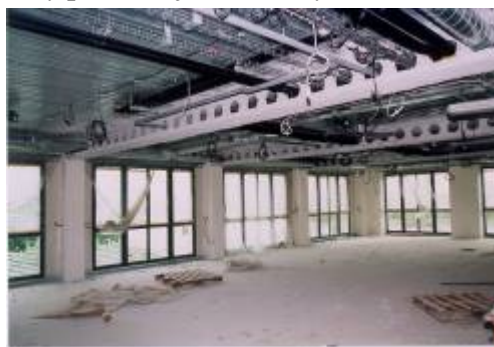
Obrázek 6.11 Nosníky s kruhovými otvory s rozvody procházejícími otvory ve stěnách [15]
