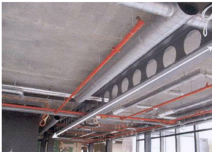
Obrázek 6.11 Nosníky s kruhovými otvory s rozvody procházejícími otvory ve stěnách [15]
