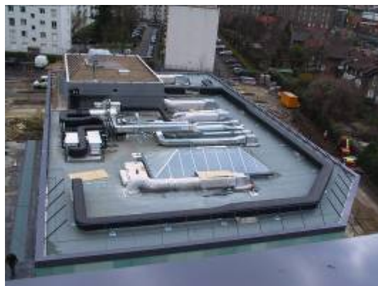
Obrázek 3.6 Typická místnost s VAV klimatickým systémem a dispoziční uspořádání na střeše budovy ukazující důležitost velkého prostoru pro potřeby systému
