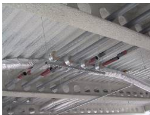
Obrázek 6.12 Příklady integrace technického zařízení v nosnících s kruhovými otvory
