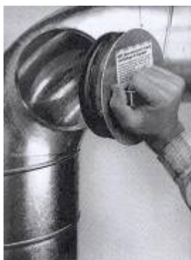
Přístup pro údržbu při "čištění" (2,0 průměry)
