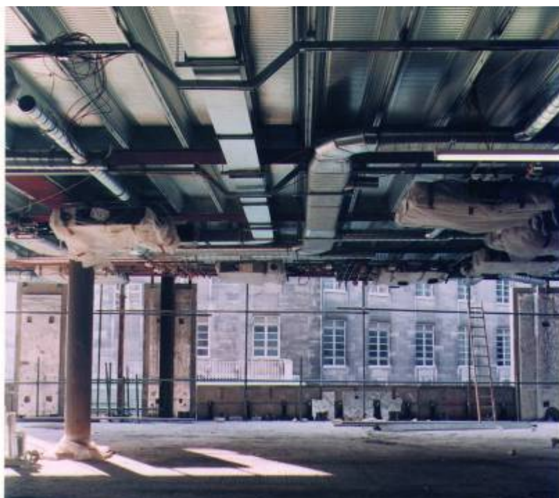
Obrázek 6.3 Technické zařízení pod systémem stropní konstrukce "Slimdek" [17]
