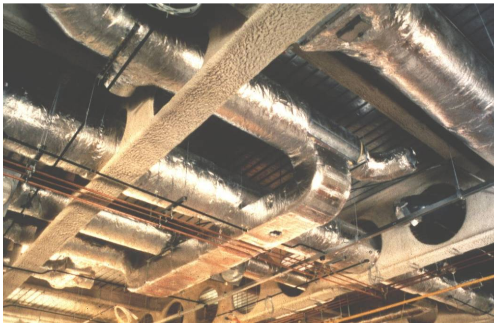
Obrázek 4.3 Potrubní rozvody a protažení otvory nosníků
