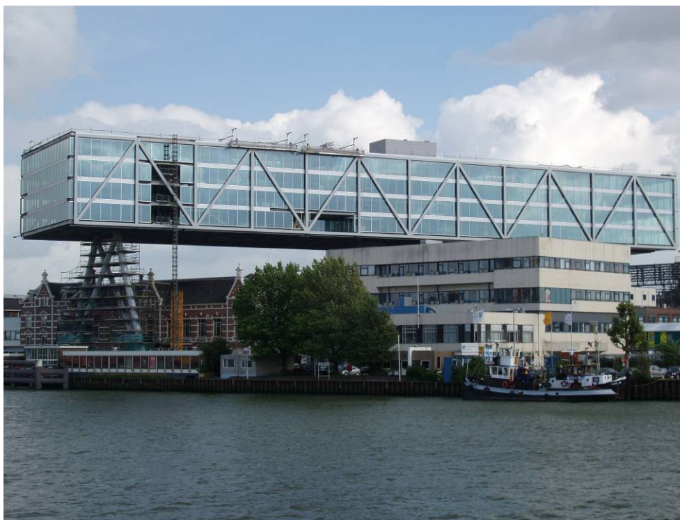
Obrázek 4.1 De Brug, Rotterdam, stavba překlenující stávající budovu
