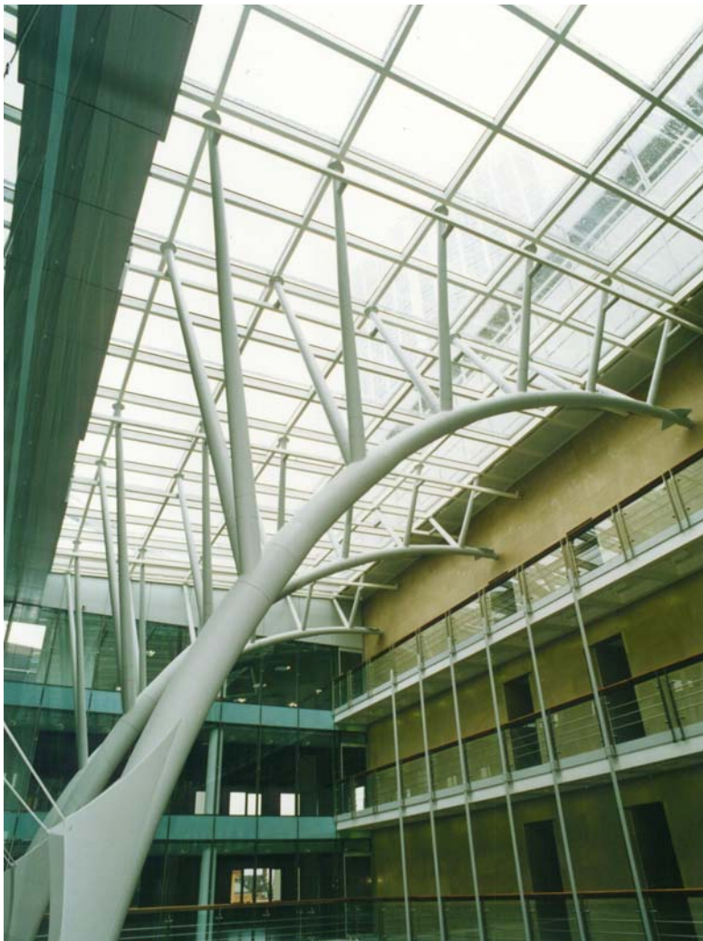
Obr. 3.2 Trubkové ocelové podpory pro konstrukci střechy nad atriem
