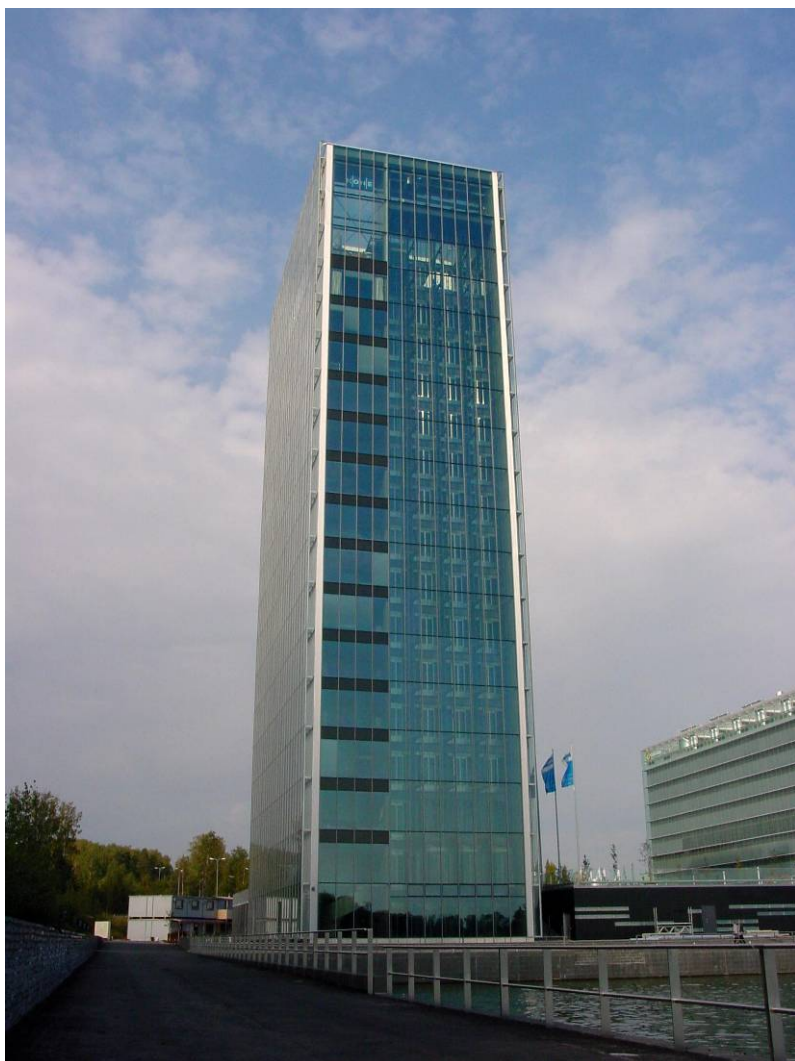
Obrázek 3.5 Budova Kone ve Finsku dosahující výšky 72 m
