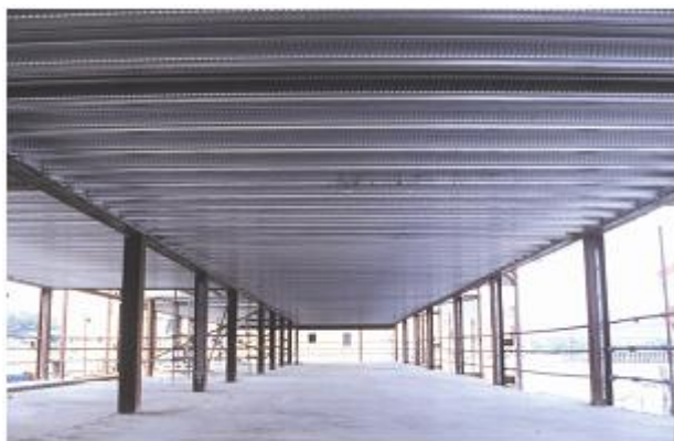
Obrázek 4.6 Nesymetrické nosníky skryté v konstrukci podlahy a nesoucí spřažený plechobetonový strop
