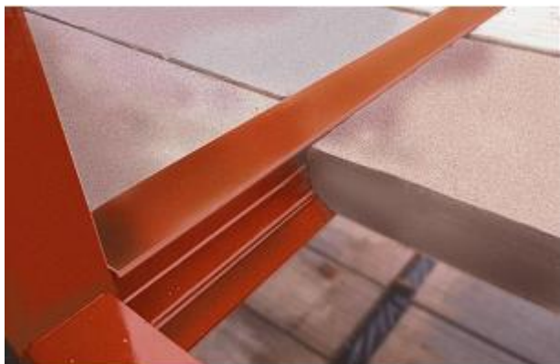
Obrázek 4.5 V konstrukci podlahy skryté nesymetrické nosníky nesoucí prefabrikované betonové desky
