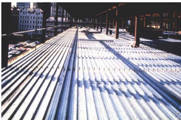
Obrázek 4.3 Spřažená konstrukce využívající ocelovou plechovou desku
