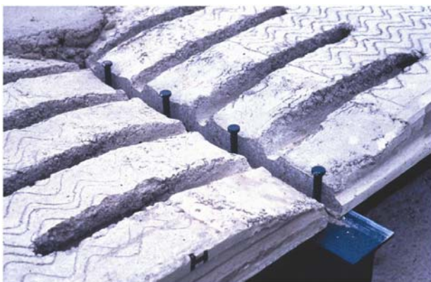
Obrázek 4.4 Ocelové nosníky umístěné pod úrovní stropu a nesoucí prefabrikované betonové desky
