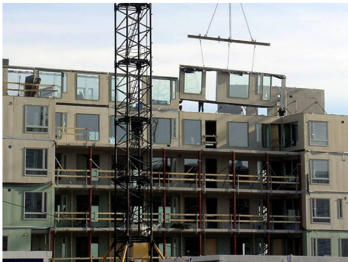
Obr. 4.4 Montáž konstrukce při osazování nosných stěnových panelů.
