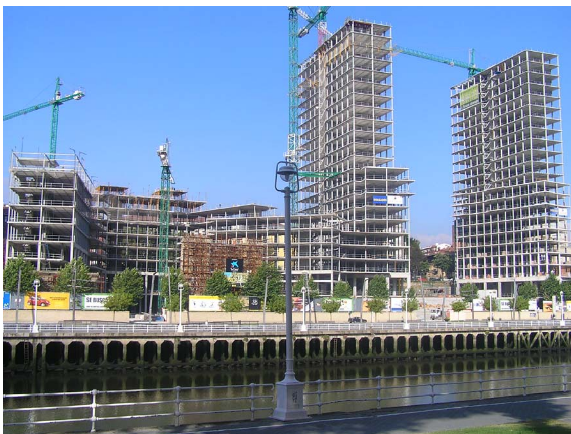
Obrázek 1.1 Pohled na staveniště po dokončení konstrukcí (červenec 2006)
