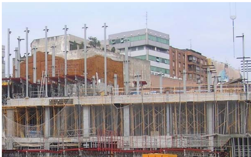
Obrázek 3.2 Železobetonové jádro a ocelové sloupy..
