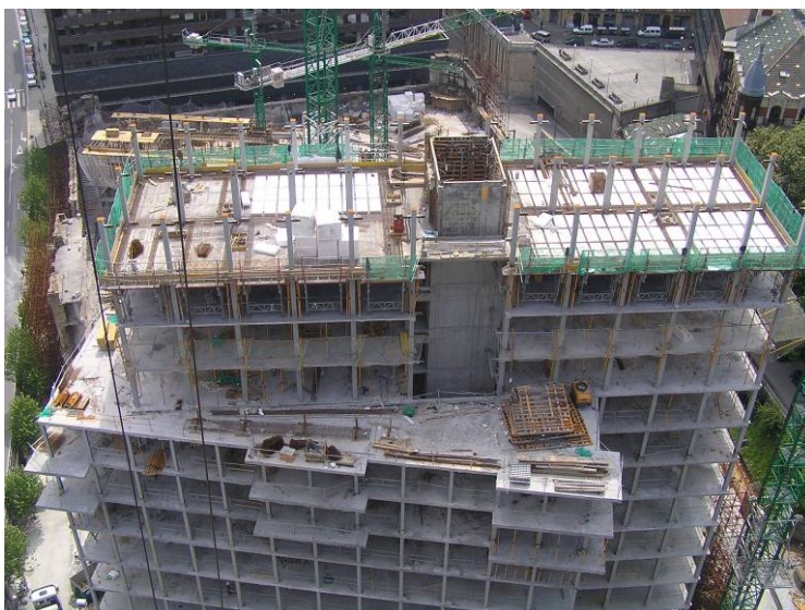
Obrázek 3.1 Centrální betonové jádro nové konstrukce.
