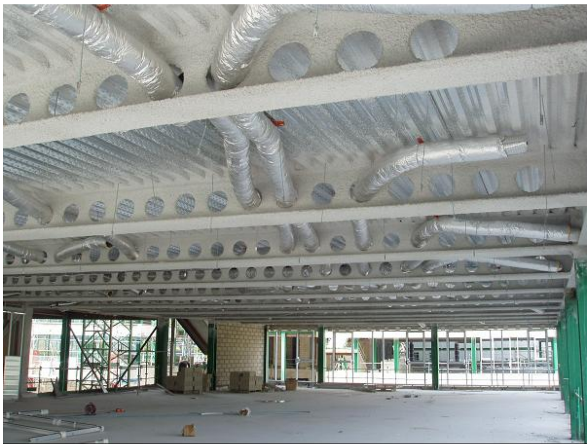
Obrázek 4.1 Celulární nosníky s pravidelnými otvory pro rozvody
