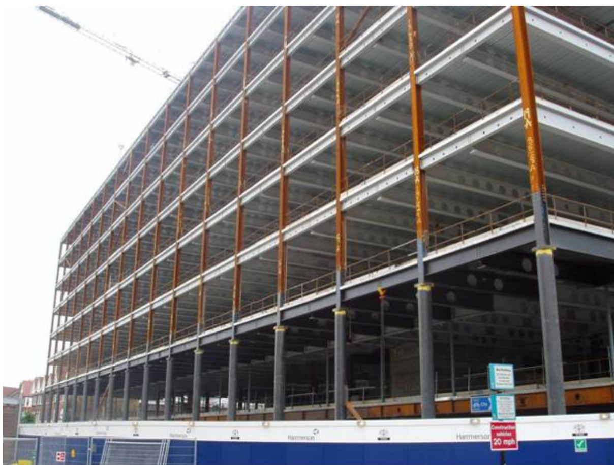
Obrázek 4.4 Trubkové a proti požáru nechráněné sloupy
