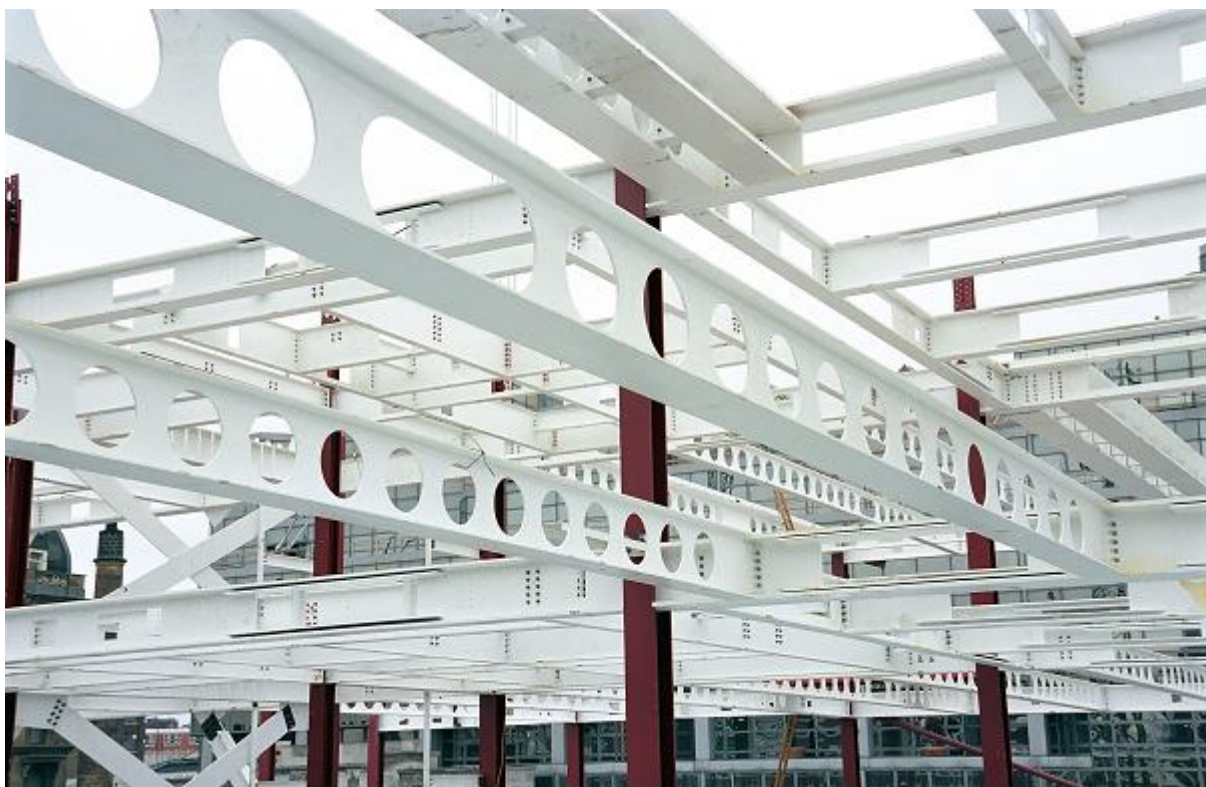
Obrázek 4.2 Svařované nosníky s různě tvarovanými otvory
