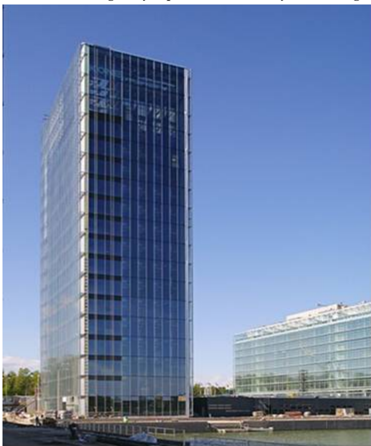
Obrázek 4.6 Dvojitá fasáda budovy společnosti Kone, Finsko
