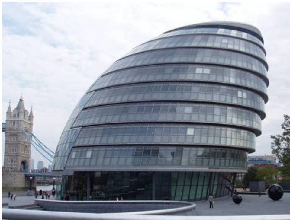
Obrázek 4.5 Energeticky úsporná budova londýnského magistrátu
