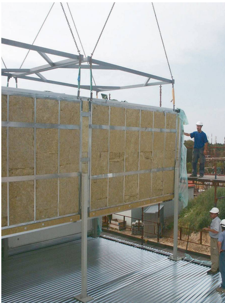
Obrázek 2.5 Osazení modulárních buněk
