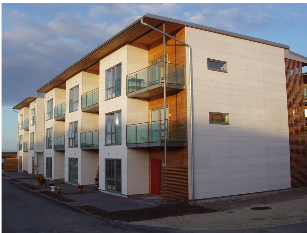
Obrázek 3.2 Řešení fasády na buňkové modulové konstrukci.
