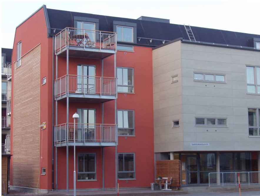
Obrázek 1.1 Čtyřpodlažní budova z modulárních buněk v projektu v Anestadu
