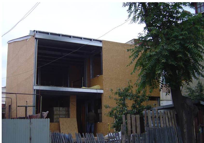
(b) Ocelový skelet s namontovanými nosnými deskami OSB
