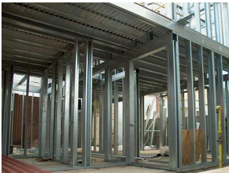
(a) dokončený ocelový skelet
