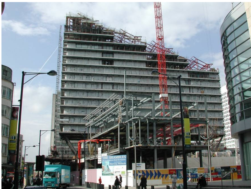
Obrázek 1.1 Superkonstrukce během montáže
