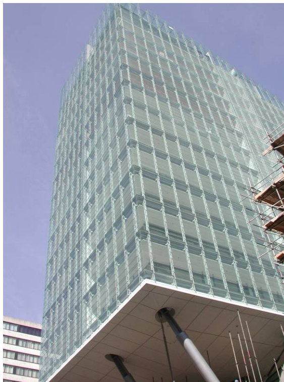
Super-konstrukce prezentuje plně prosklenou fasádu a šikmé sloupy
