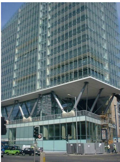
Obrázek 1.2 Šikmé sloupy v podnoží budovy
