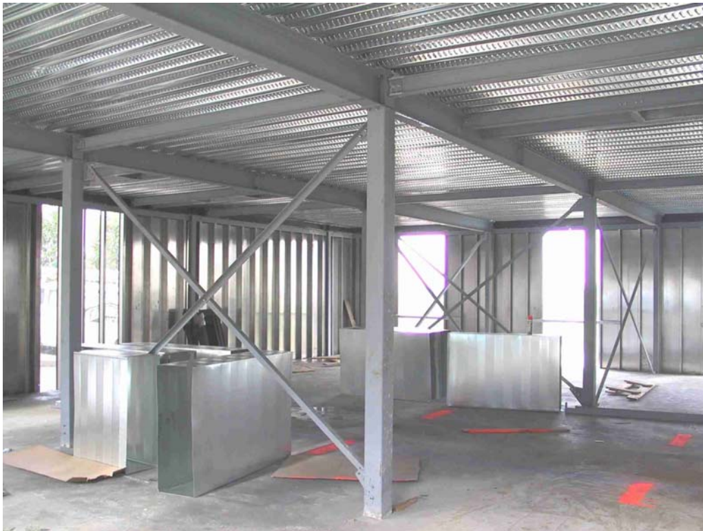
Obrázek 3.2 Pohled na vnitřní konstrukci
