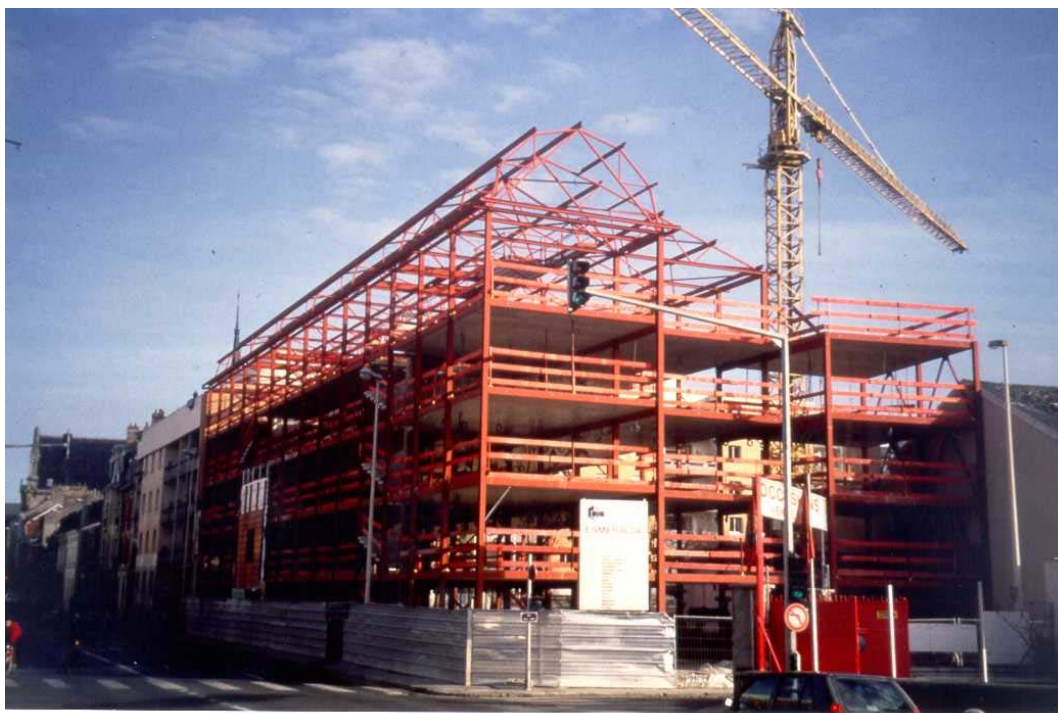
Obrázek 3.1 Budova během výstavby
