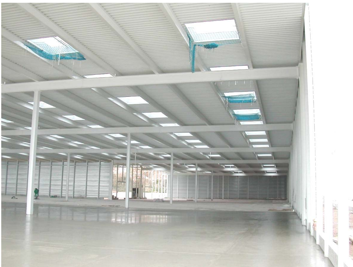
Obrázek 2.4 Nosná konstrukce supermarketu
