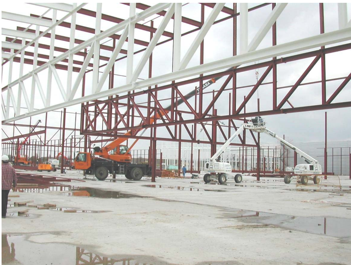
Obrázek 2.5 Montáž ocelové konstrukce
