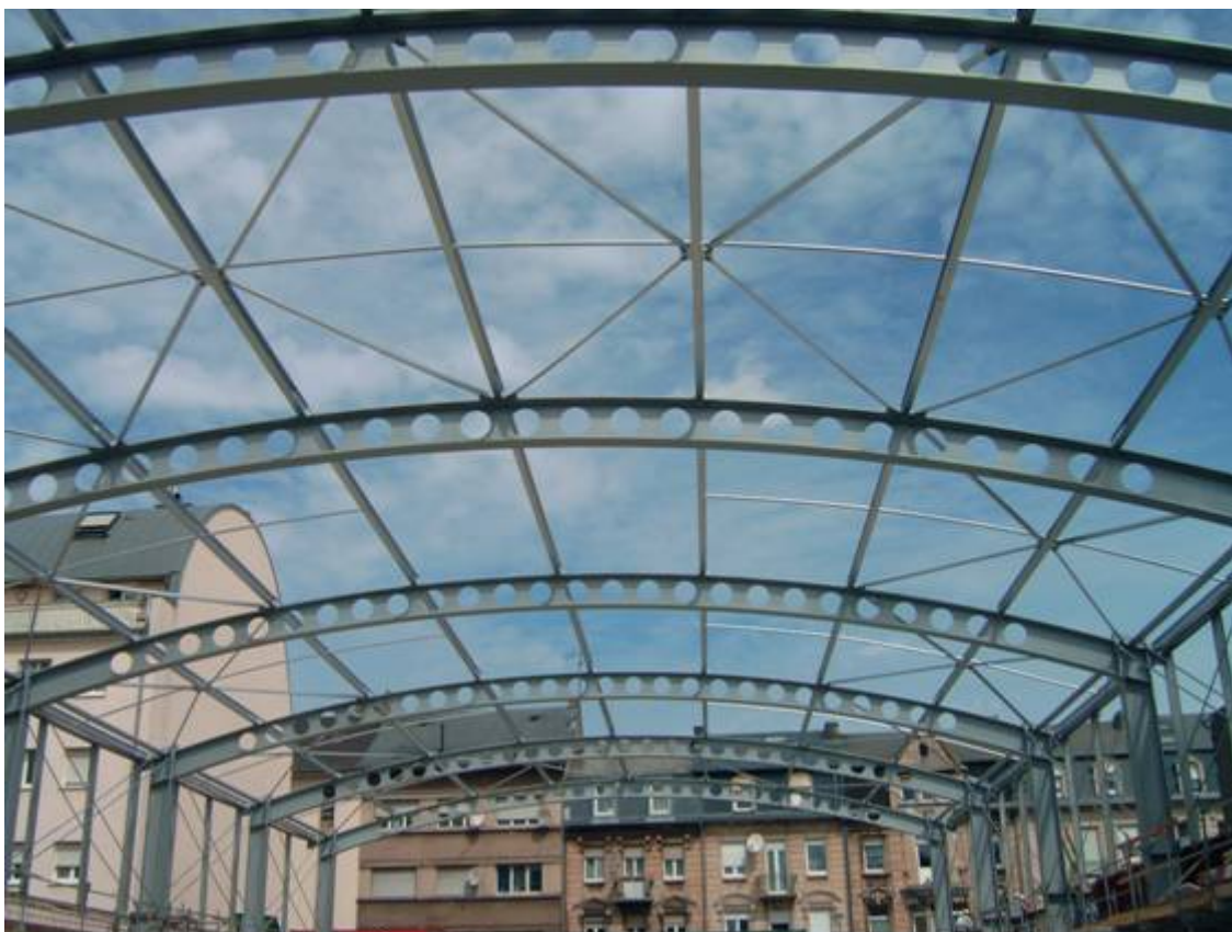
Obr. 2.1 Pohled na budovu během výstavby
