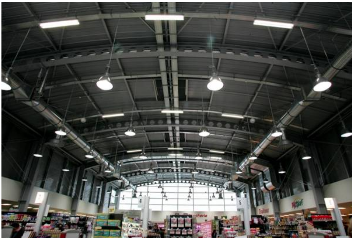
Hlavní nosná konstrukce nákupního centra
