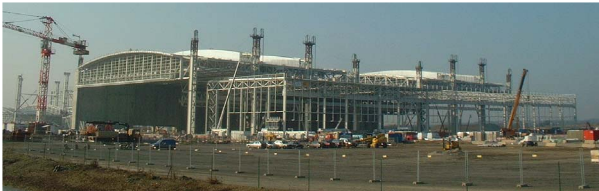
a) Pohled na halu během montáže
