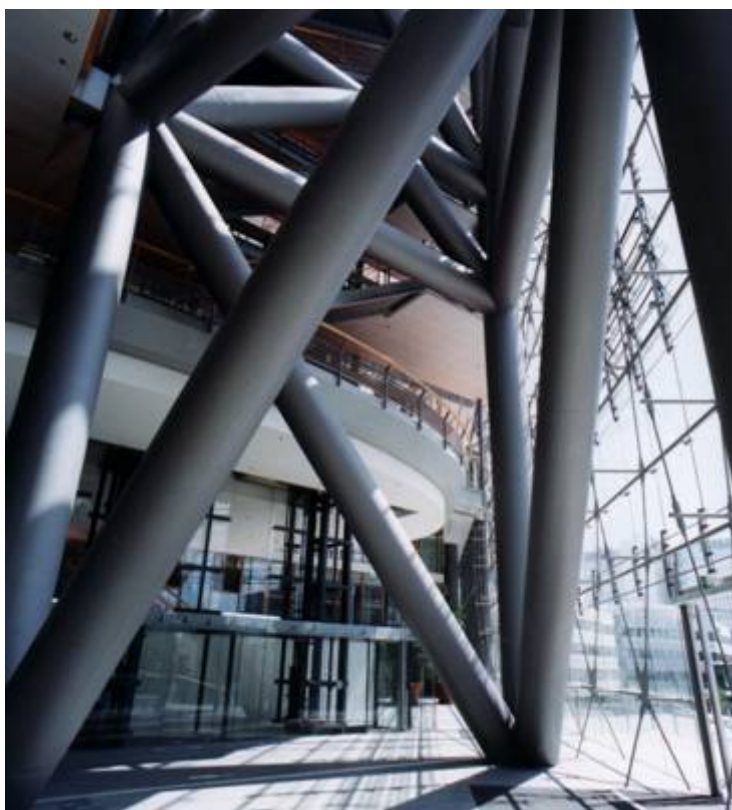
Obr. 4.2 Příhradová věž provedená z kruhových průřezů (Copyright foto se svolením ThyssenKrupp Stahl AG)
