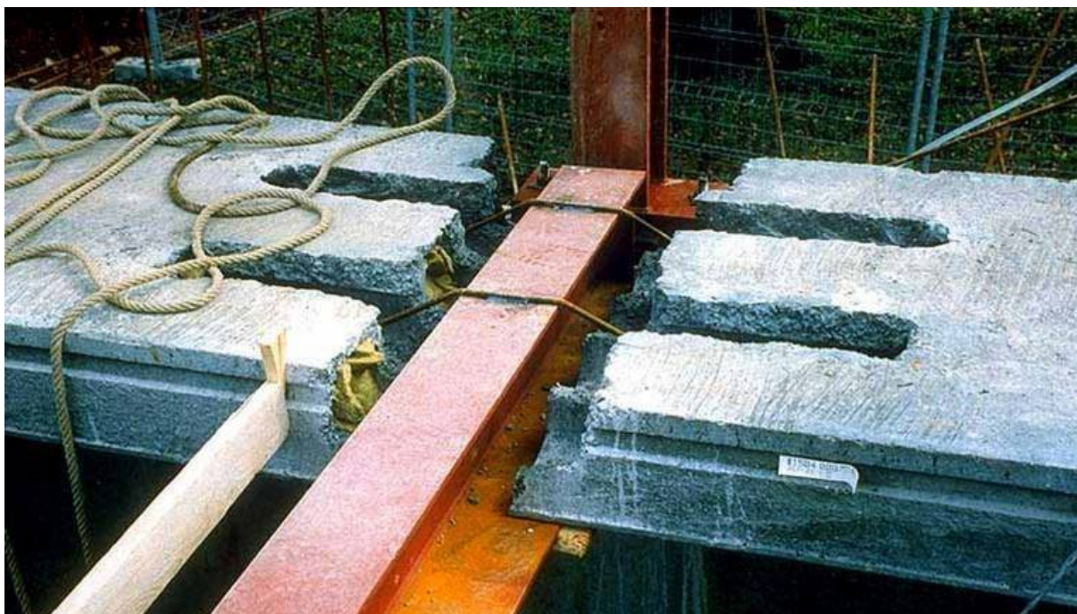
Obr. 3.3 Výztuž v desce z požárních důvodů
