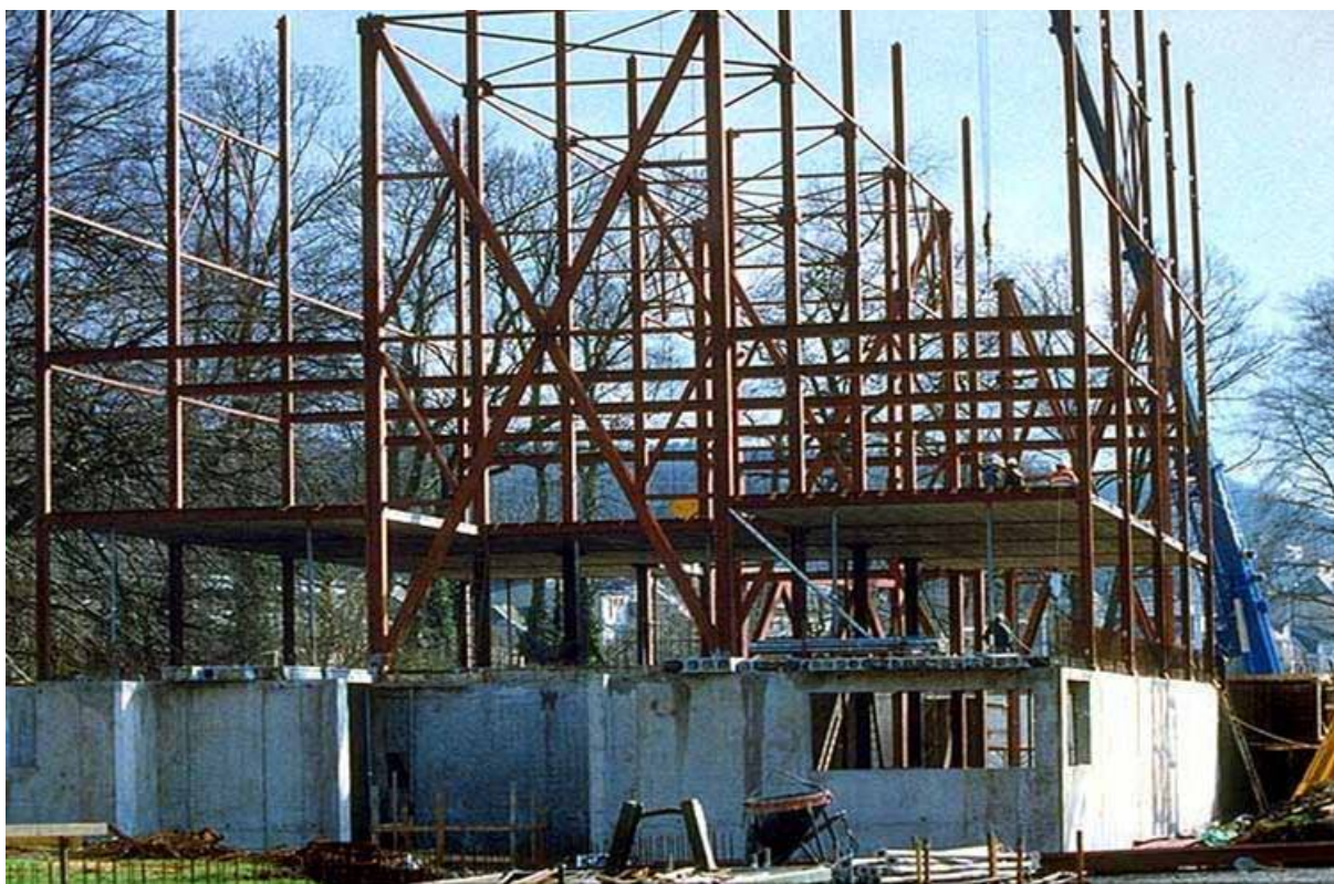
Obr. 3.1 Ocelová konstrukce budovy během montáže
