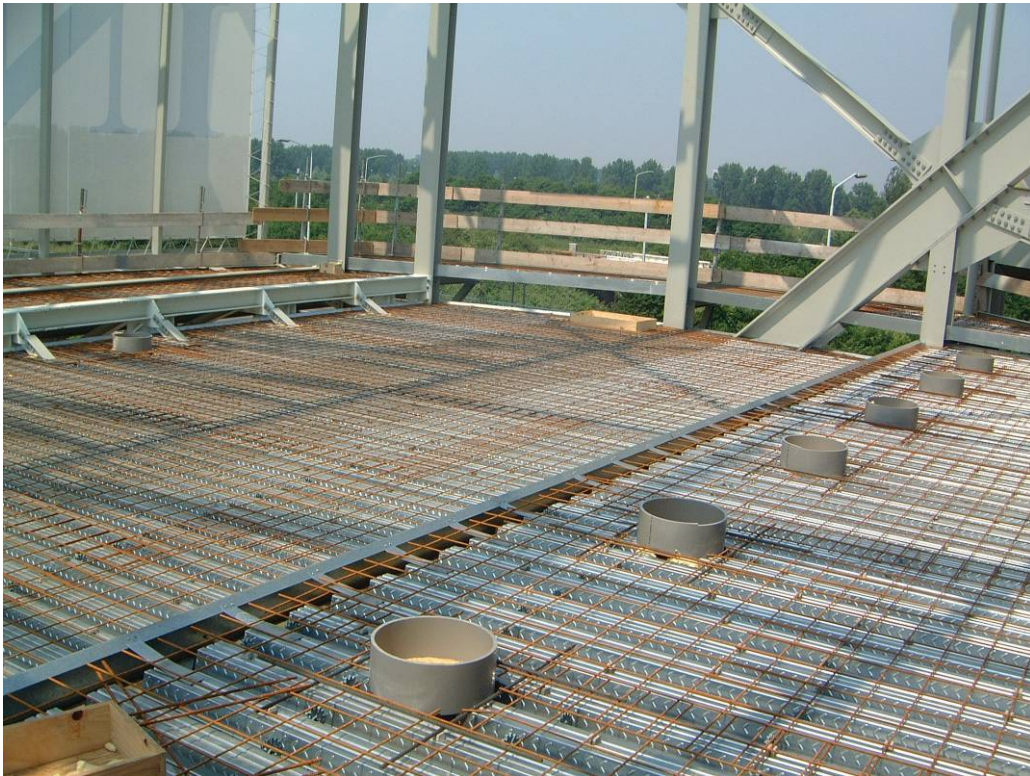
Obrázek 2.1 Bednění a výztuž spřažené desky auditoria s průchody pro rozvody.
