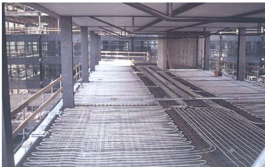
Obrázek 2.1 Trubky pro vytápění/chlazení uložené ve stropní konstrukci.
