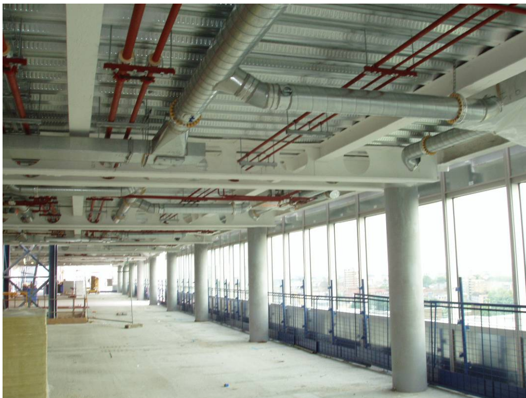
Obrázek 2.1 Rovnoběžné průvlaky s kruhovými otvory
