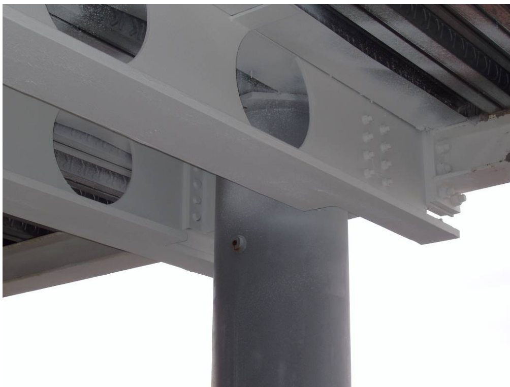
Obrázek 2.2 Detail připojení průvlaků na sloup
