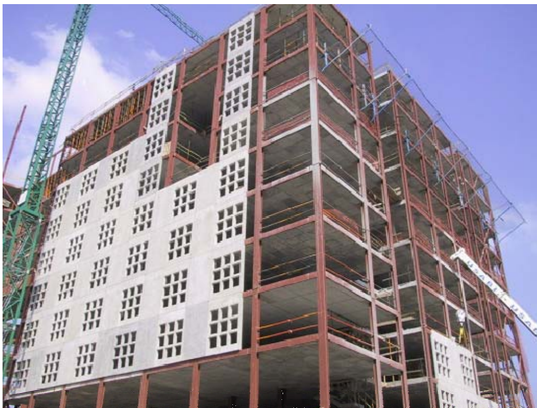
Obrázek 2.1 Použití ocelové konstrukce a prefabrikovaných panelů obvodových stěn redukovalo dobu výstavby a umožnilo vyhovět požadavkům architekta .
