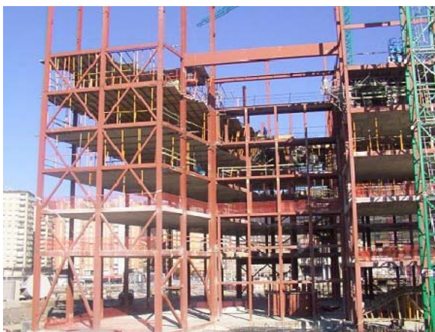
Obrázek 4.1 Pohled na ocelovou konstrukci atria a zavětrování.
