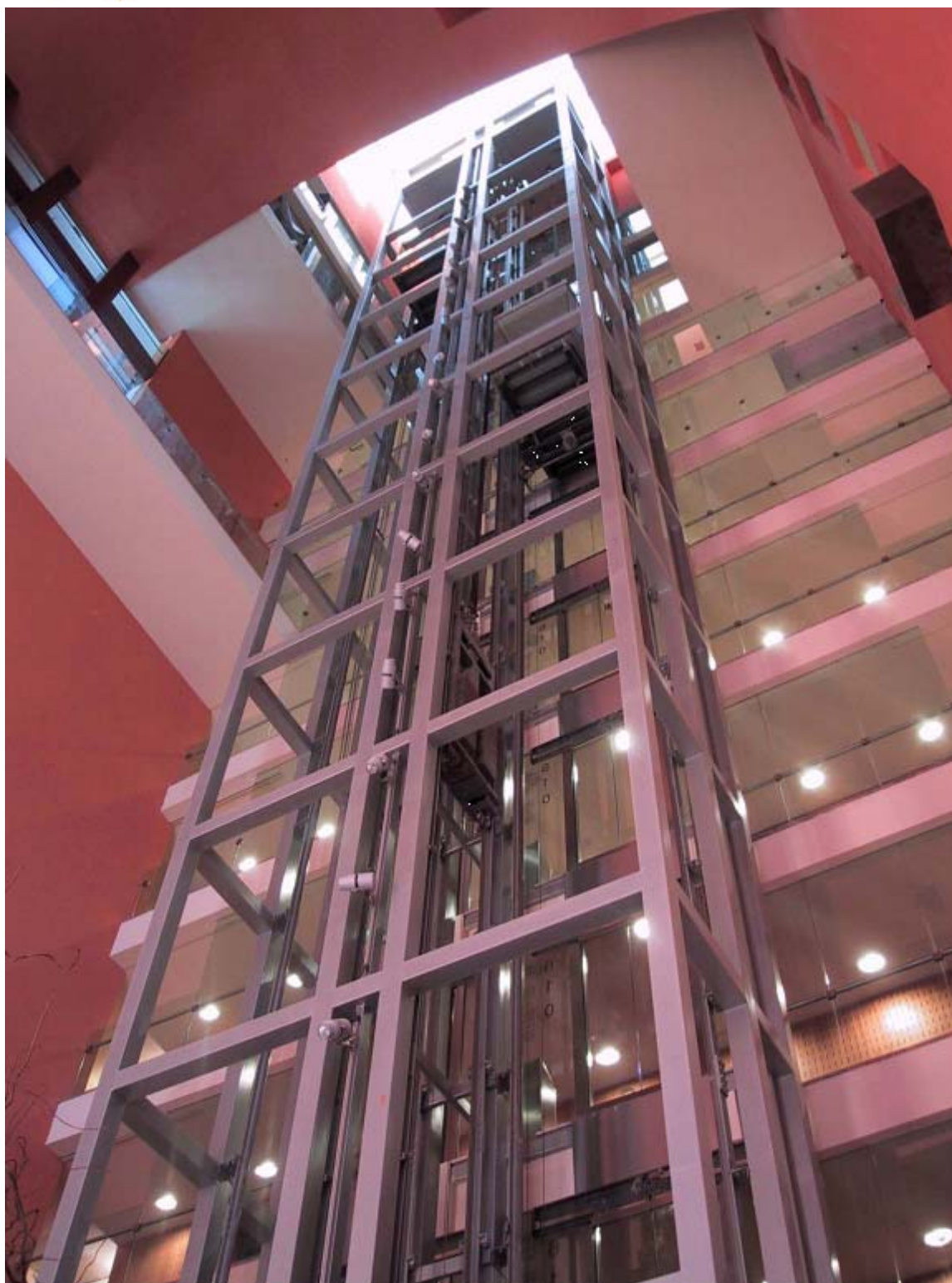
Obrázek 3.5 Ocelová konstrukce výtahů v atriu.
