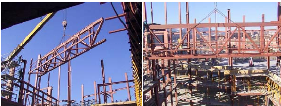
Obrázek 4.4 Montáž příhradových konstrukcí nad atriem.
