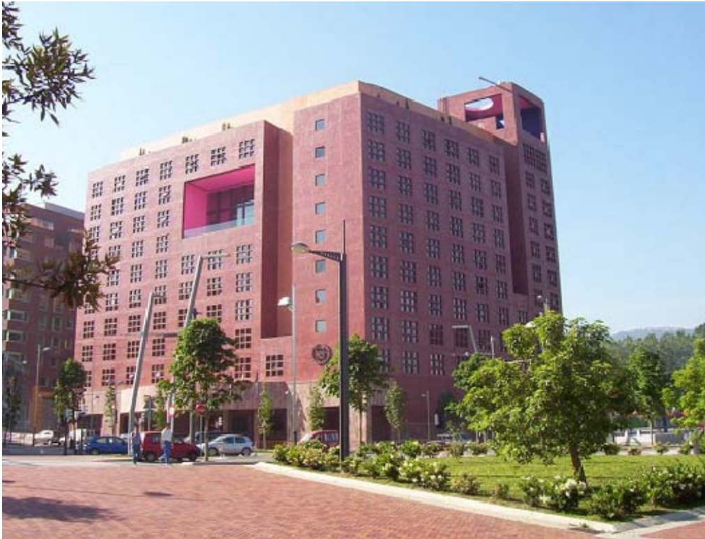
Obrázek 3.1 Pohled na hlavní vchodovou fasádu.
