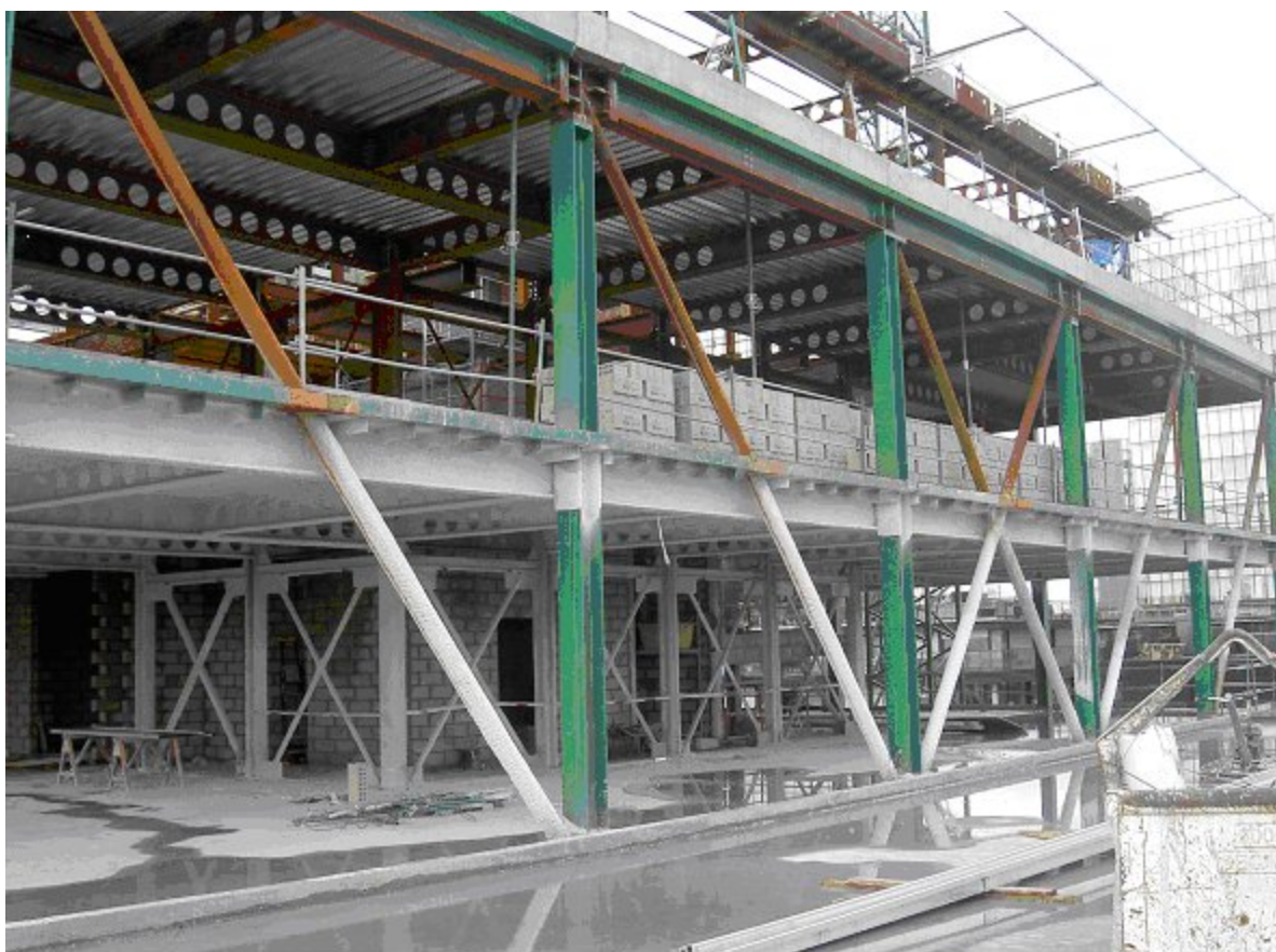
Obrázek 6.1 Uspořádání ocelové konstrukce. Zavětrování vynáší vnitřní konzoly
