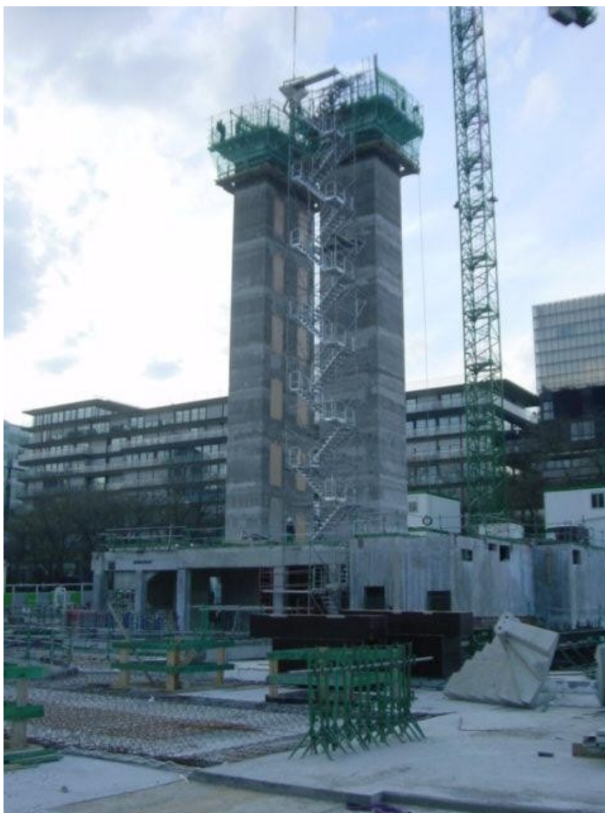
Obrázek 5.1 Sedmipatrová jádra v posuvném bednění
